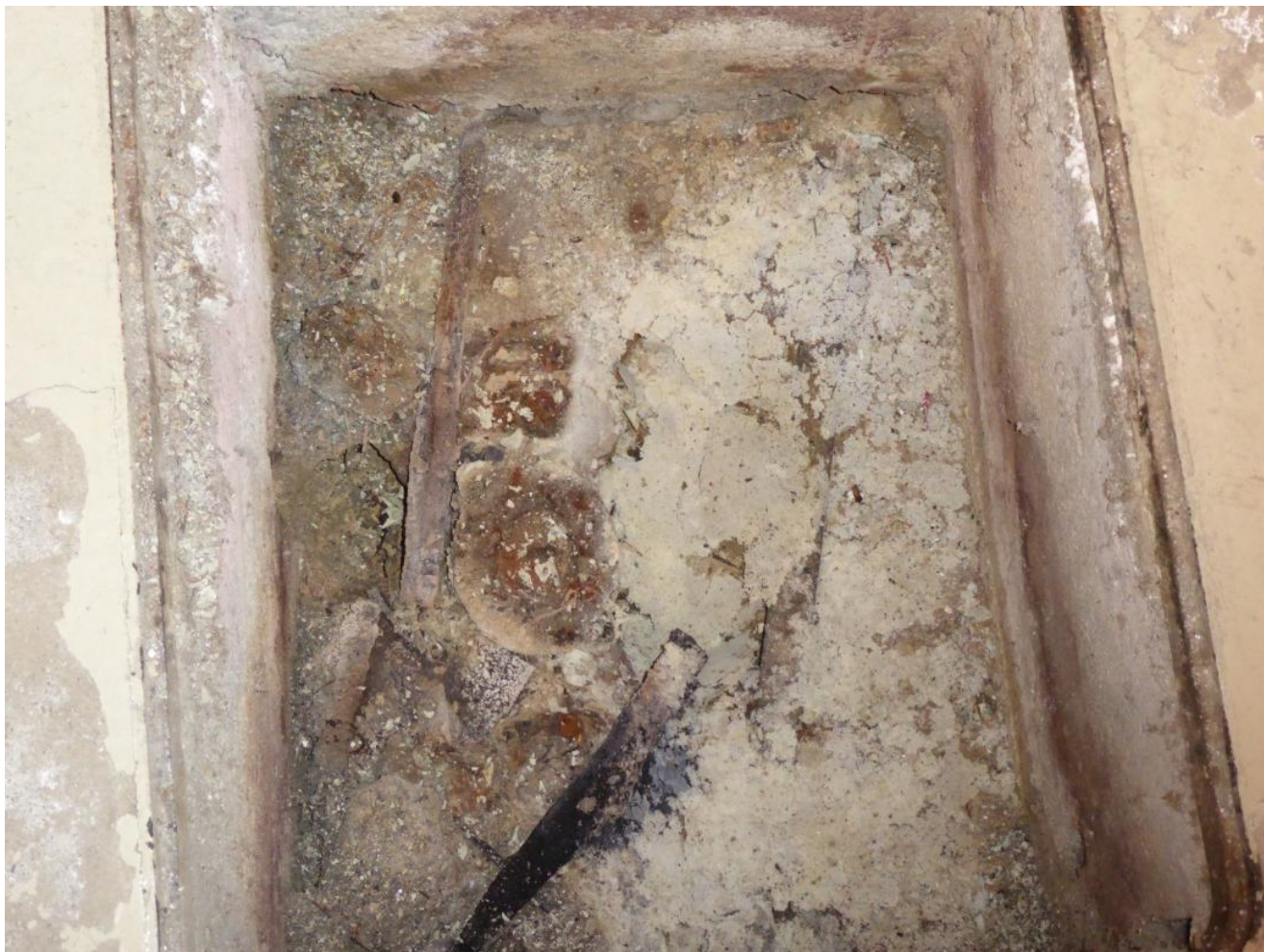
Rustet avløpsrør. Stakekum tidligere fylt med vann.
