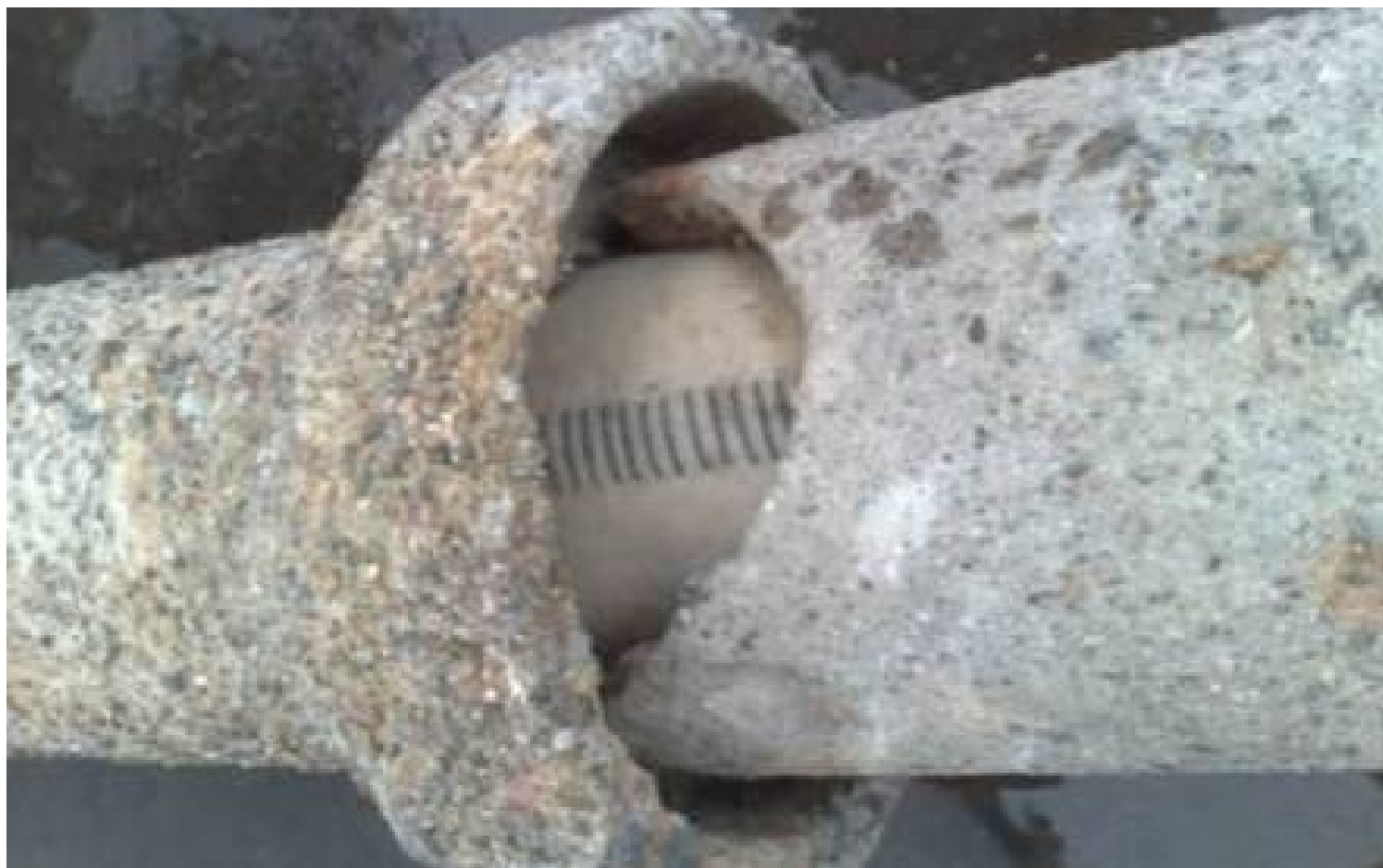
Rustet avløpsrør. Stakekum tidligere fylt med vann.
