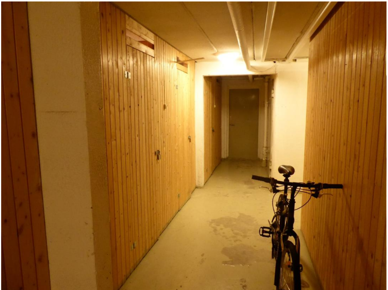
Tette boder med lufting over dør.
